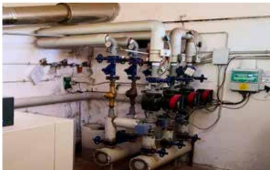
Immagine 2 Impianto con caldaia a basamento a condensazione © Termogestione.it
